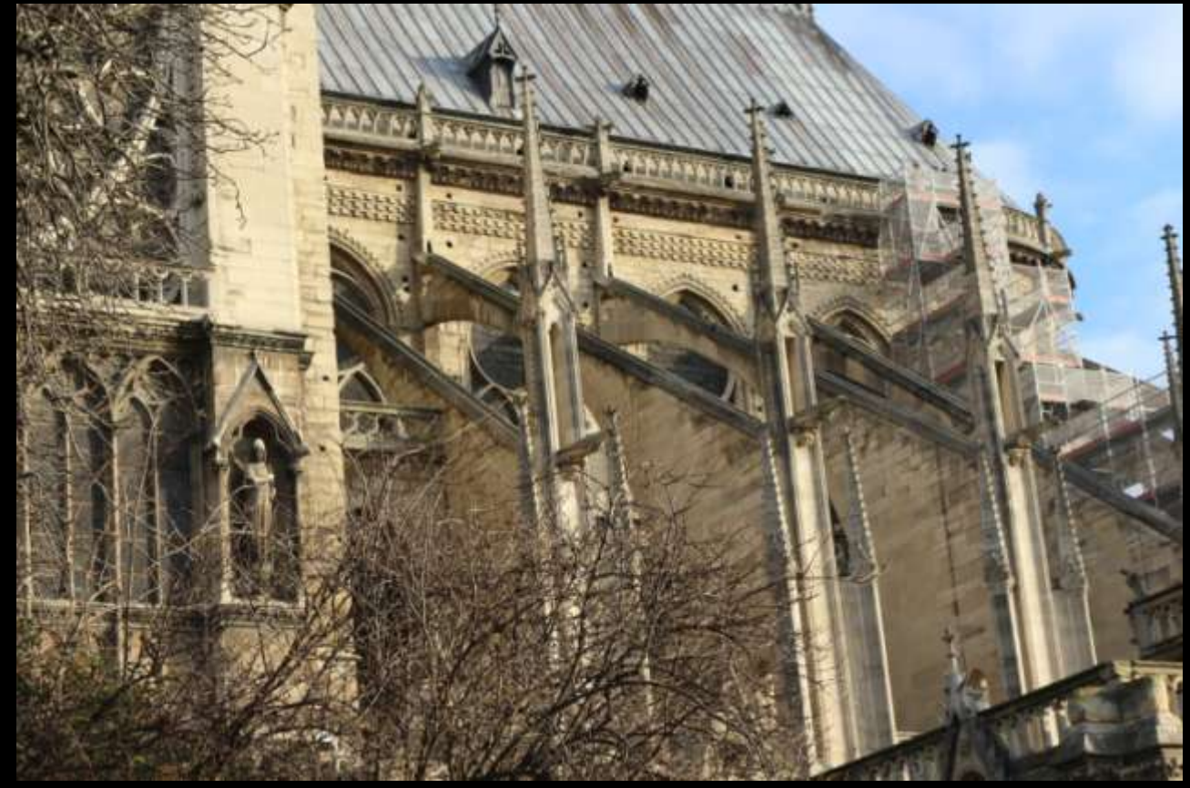
Detalhe do arcobotante da Catedral de Notre-Dame de Paris. Início da construção 1163, fim da construção 1345, diocese Paris, França.
