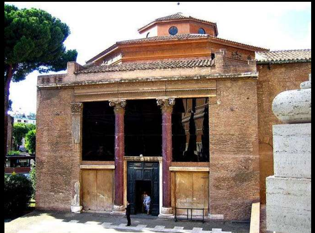
Entrada do batistério de São João Latrão
