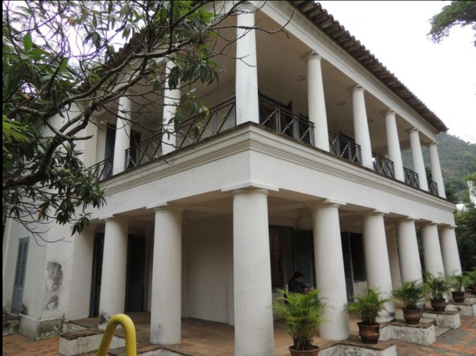
Solar Grandjean de Montigny, fachada posterior.
